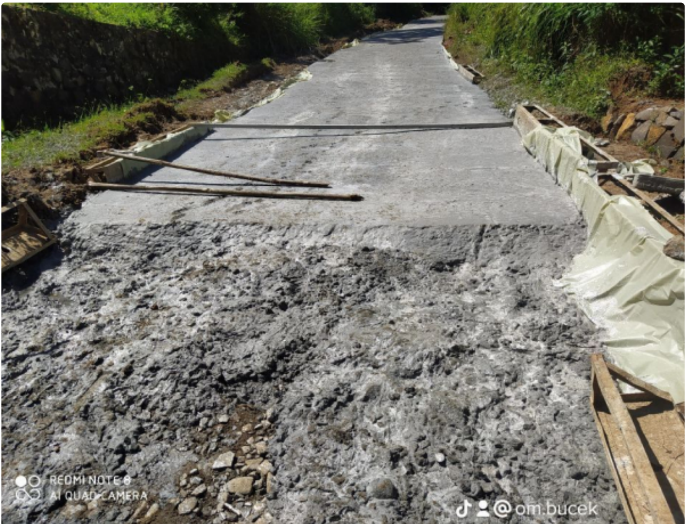
Pengerjaan Cor beton rehabilitasi jalan Cihara-Sukahujan
